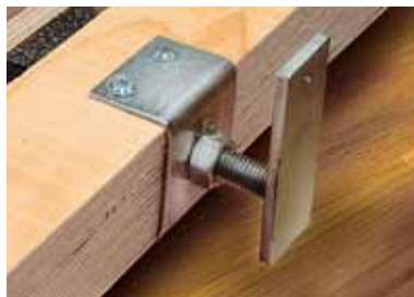
Неровности подложки можно устранить с помощью регулировочных металлических ножек.
